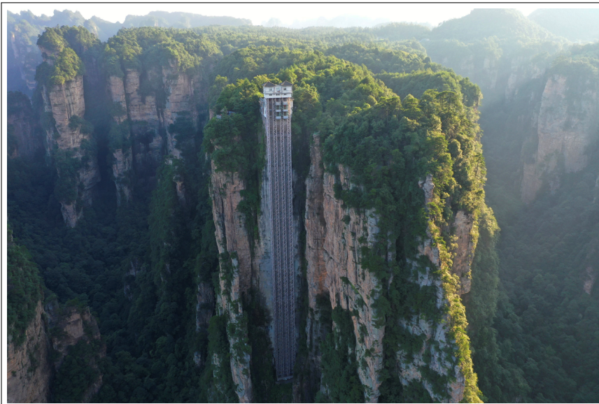
FIGURE 2 – Structure métallique de la partie extérieure des ascenseurs
